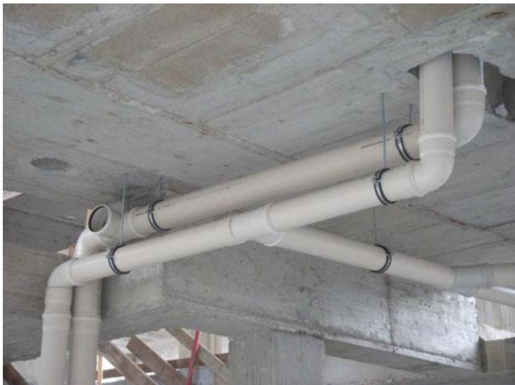
**Figura 1.4 - Instalaciones de evacuación colgadas bajo losa de hormigón**
