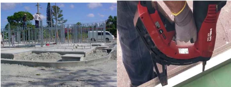
Ejemplo de ejecución de replanteo y colocación de canales inferiores.
