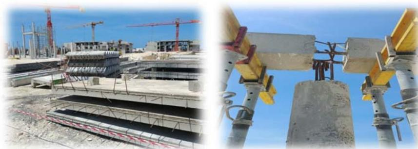
Prefabricación liviana: Es el tipo de prefabricación que produce elementos manejables manualmente o por equipos de baja capacidad. El peso debe ser inferior a 300 kgf. La producción puede ser realizada totalmente en la obra o por razones industriales en un taller.
