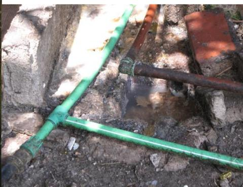
Fuente: Foto tomada en el lugar, mal estado de las instalaciones hidráulicas, expuestas.
