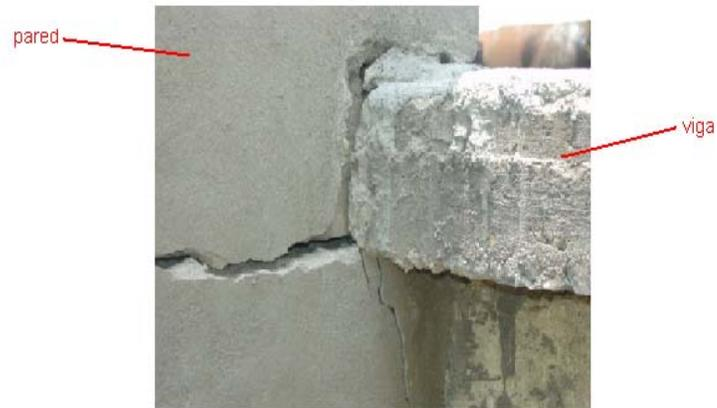
Foto de separaciones entre elementos estructurales de una vivienda
