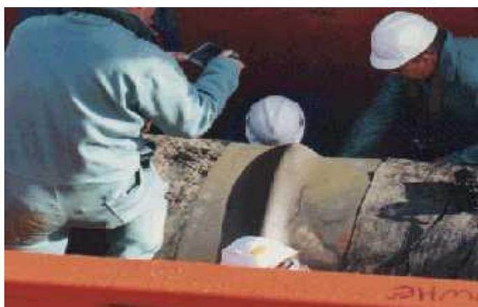
**Figura 21:** Colapso por incremento de temperatura, sin compensadores de dilatación.
