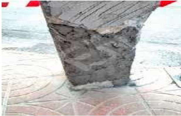
**Figura 44:** Desagregación
