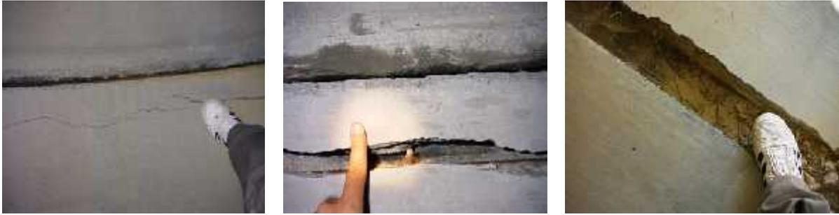
**Figura 11, 12, 13:** Tres fases de patología por el mismo problema de falta de armadura en la junta.
