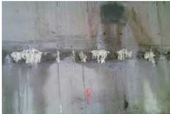
**Figura 45:** Fuga en junta de hormigón
