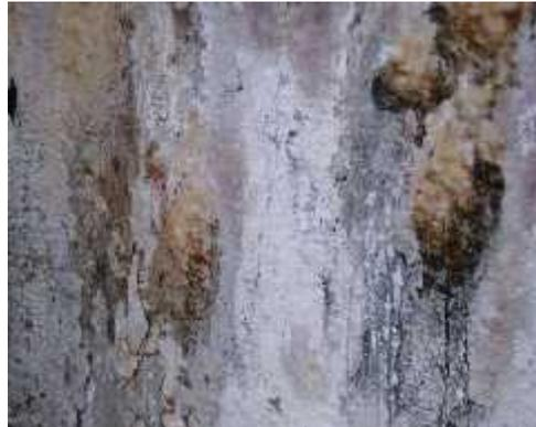
**Figura 5 y 6:** Corrosión del acero de refuerzo y manchas por humedad.
