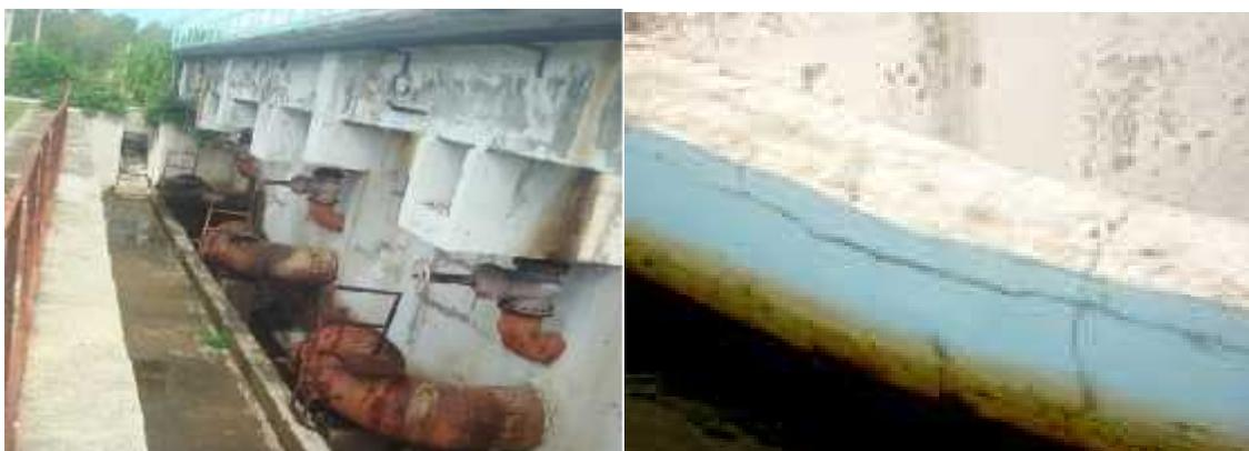
Figuras 8 y 9: Corrosión en la galería de válvulas de los filtros y fisuras y grietas en el hormigón.
