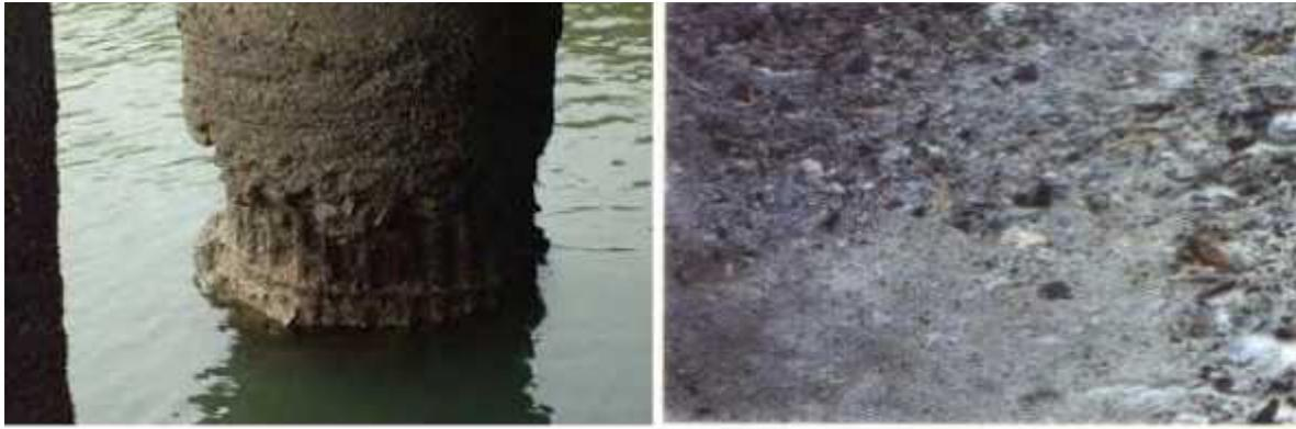
**Figuras 38 y 39: Cavitación en estructuras de hormigón**
