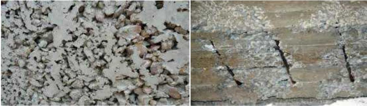
**Figuras 42 y 43:** Disgregación en el hormigón
