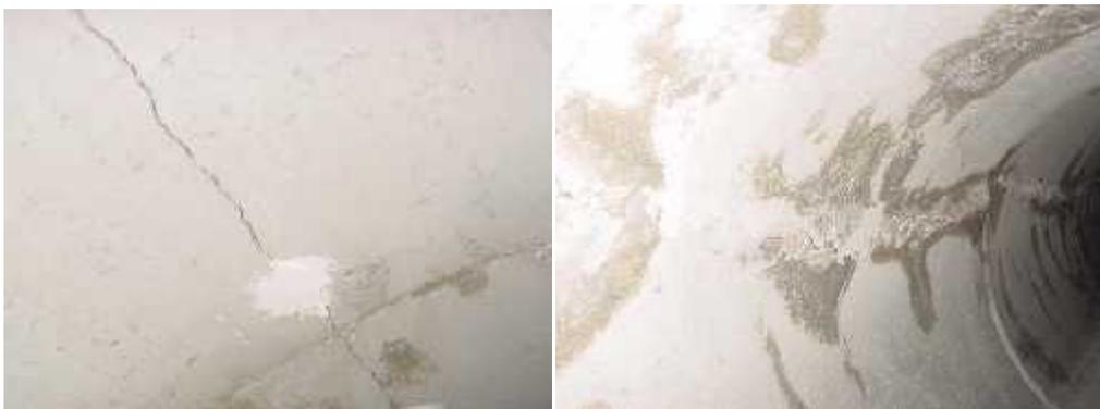
**Figura 14, 15:** Fisura en clave sin apertura y fisuras diámetro.
