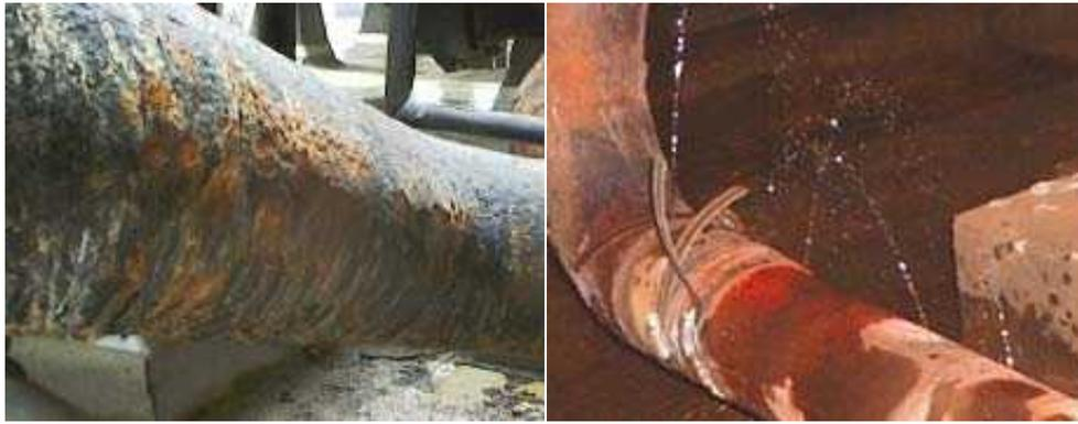
**Figura 26:** Patología por corrosión generalizada en tubería de acero.
