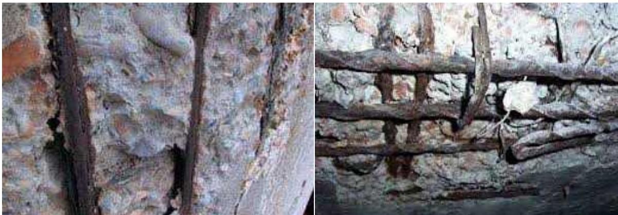
**Figuras 40 y 41: Carbonatación en el hormigón armado**
