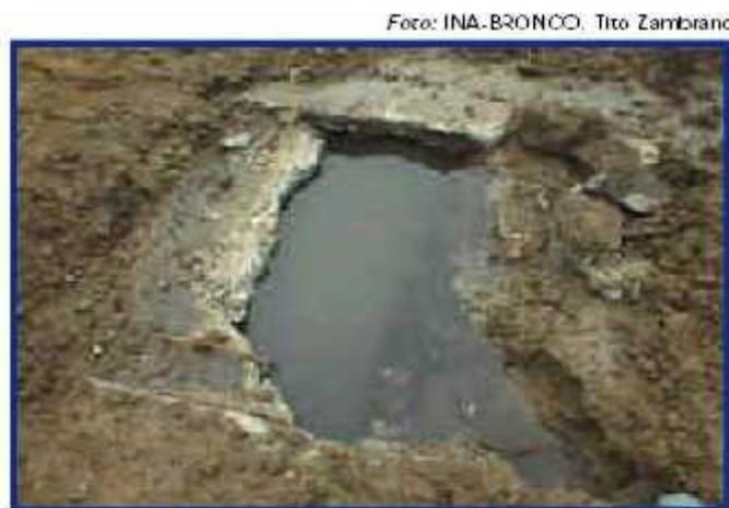
**Figura 24:** Corrosión de la clave de tubería de hormigón por presencia de sulfuro de hidrógeno.
