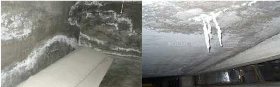
**Figuras 36 y 37:** Eflorescencia en el hormigón
