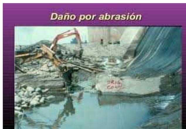
**Figura 35:** Daño por abrasión.
