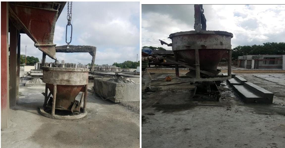
Figura 2.7: Proceso de llenado y colocación del hormigón en los moldes en la planta de prefabricado. Transportación del hormigón con grúa pórtico
