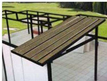
Los paneles para la losa de techo se colocan uno al lado del otro sin necesidad de apuntalar montándose sobre la estructura
