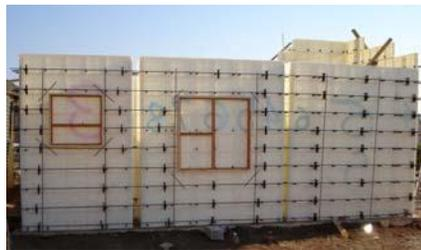
**Fig. 2** Acero de refuerzo y marcadores de ventanas
