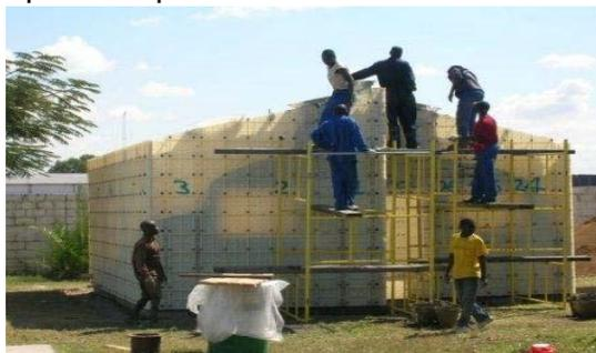
**Fig. 3** Ensamblaje del encofrado
