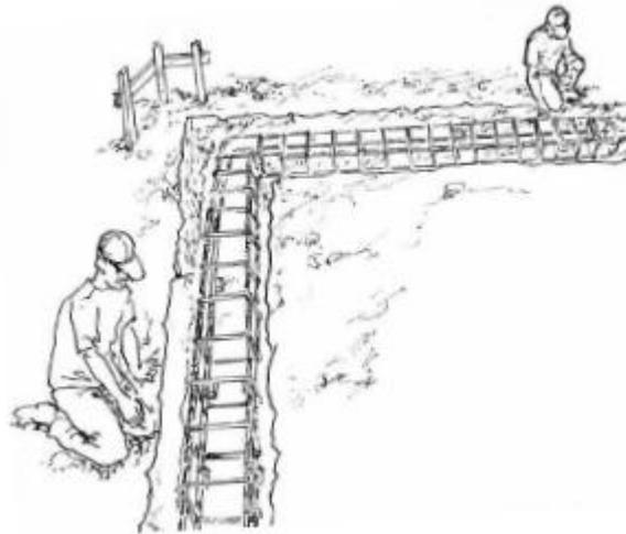
**Fig. 22** Colocación de acero de cimentación
