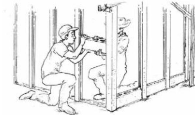
**Fig.6** Colocación de bloque panel
