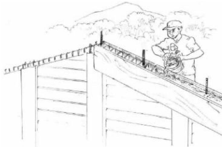
**Fig. 42** Encofrado de viga de cerramiento
