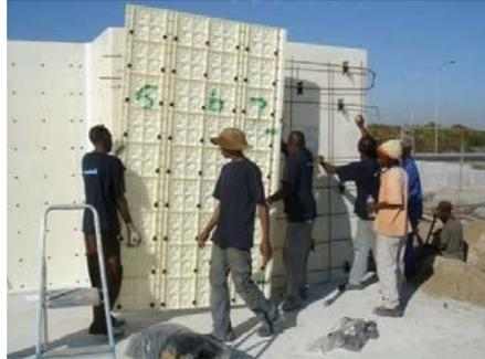
**Fig. 1** Ensamblaje del encofrado
