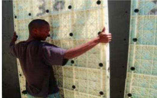
**Fig.4** Desencofrado de paredes
