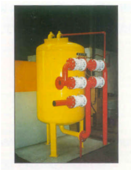
Figura 2: Unidad de Filtración Rápida.
