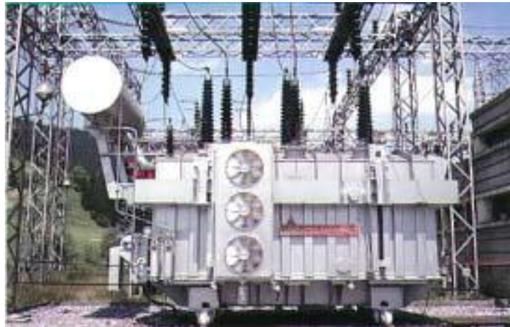
Figura 1.3. Transformador trifásico de potencia
