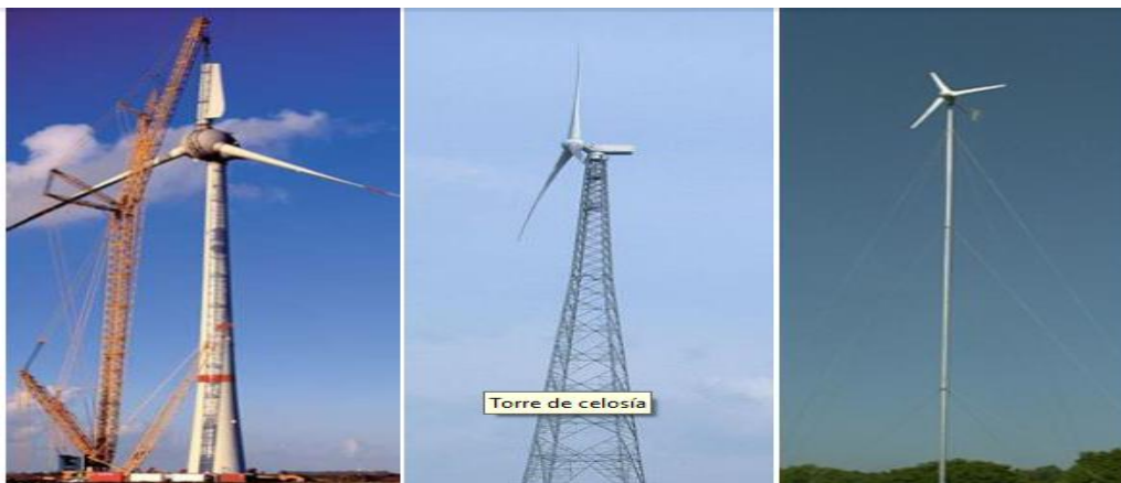
Fig 1.3 Tipos de aerogeneradores de eje horizontal
