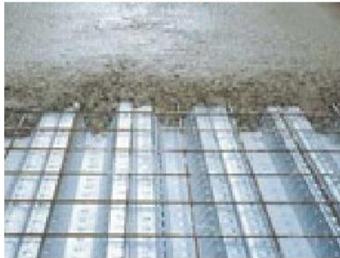
Fig. 1. 8 Disposición de la malla en la losa
