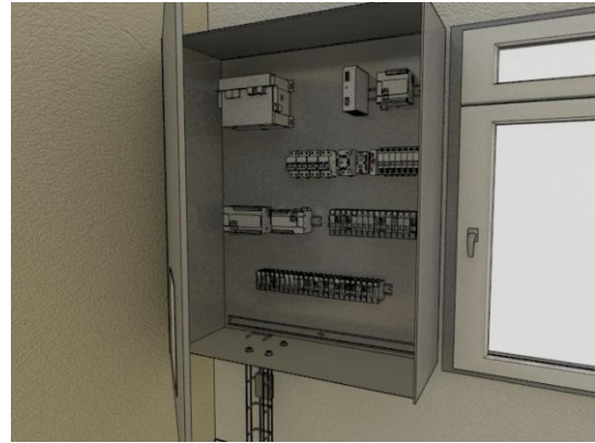
Figura A.6 Vista interior del armario donde encuentra el PLC, Módem GPRS, etc.
