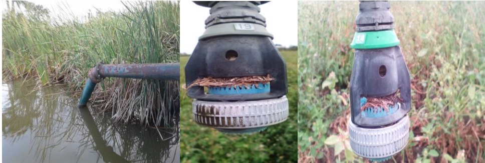
Figura 5. Fuente de abasto y boquillas obstruidas
