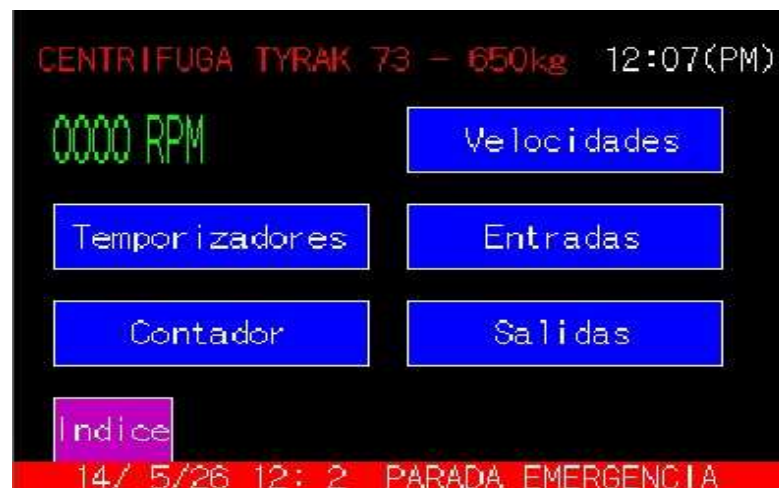
Figura 3.2. Aparición de la falla PARADA POR EMERGENCIA
