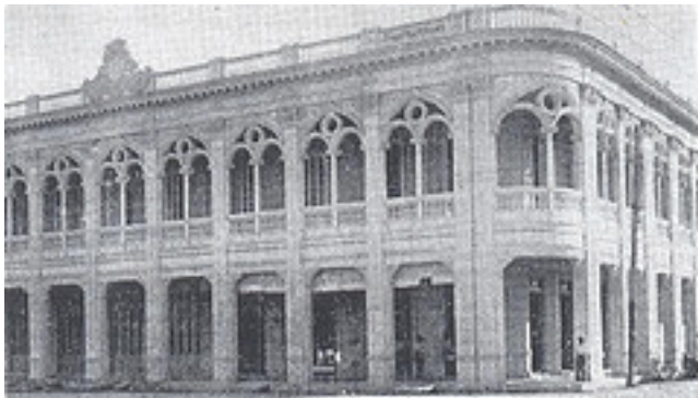
Edificio construido en 1873 para la Sede del Recreo de Artesanos, de madera y con un solo piso, el 31 de Enero de 1910 cambia su nombre por el de "Liceo de Caibarién". El 26 de Febrero de 1926 se inauguró como "sociedad de Instrucción y Recreo".
