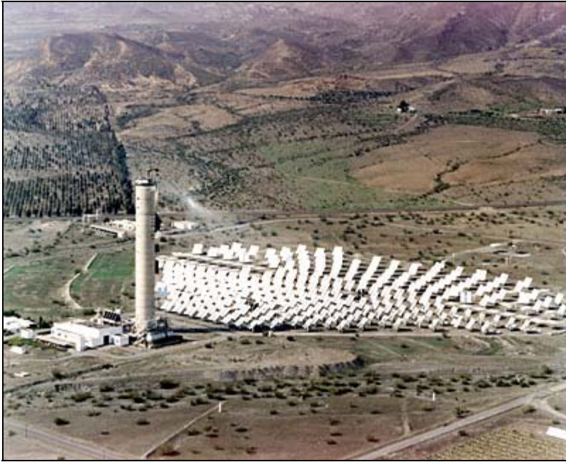
Fig. 1 Termoelectrica que funciona mediante la energía solar térmica.
