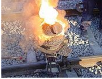
Figura 1.2: Termita reaccionando para soldar un riel ferroviario. Después de esto el hierro líquido fluye dentro del molde alrededor del perfil de la vía.
