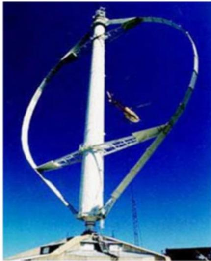
Figura 1. 9 Aerogenerador Darrieus.
