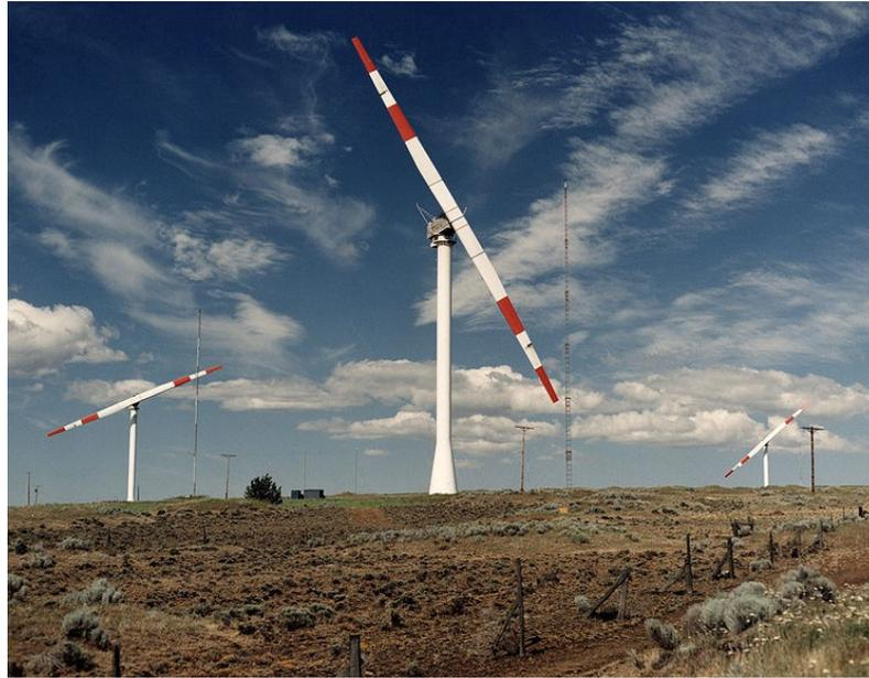
Figura 1. 4 Aerogenerador bipala.
